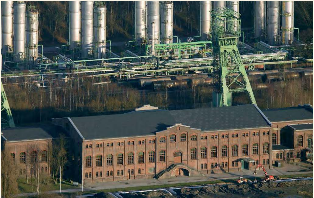
Die Maschinenhalle in Zweckel mit Fördertürmen, dahinter Anlagen von Ineos Phenol
